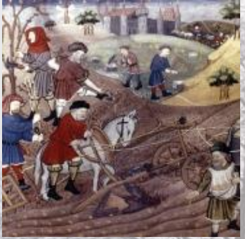
Curage des fossés
